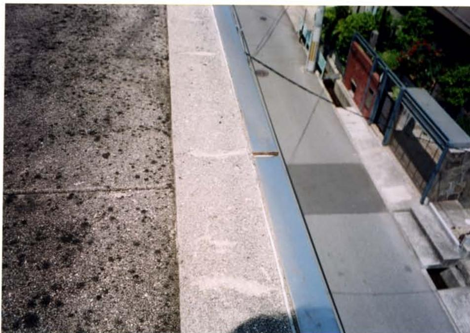
モルタルの劣化及びステンレス金物の取り付けコーキングが劣化しています。
